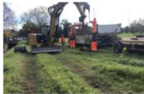
Lavori nell'area dell'ospedale
