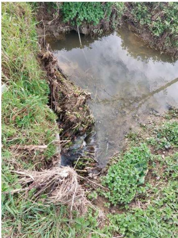
L'acqua scorre soltanto su uno di questi tubi del mille la cui sezione è come si vede comunque notevolmente ridotta per interrimento. L'altro tubo è completamente chiuso (vedasi acqua ferma).
