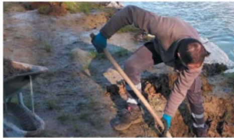
Lavori in Valdarno Il Consorzio di Bonifica sta operando sui torrenti
