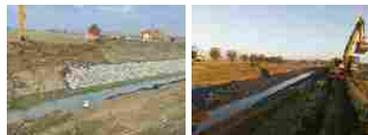
Gli interventi sono finalizzati alla ricostruzione dell'alveo, nei tratti ammalorati, con pietrame, geotessuti e palificazioni al piede, e riguarderanno circa 4 km di percorso del Diversivo in valle, fino alla foce nel canale Destra Reno. Nello specifico, tra la rotonda del Ranocchio e la ferrovia si interverrà solo in alcuni tratti del canale, mentre dalla ferrovia fino alla foce i lavori riguarderanno l'intero corso dello scolo, con ricreazione della sommità arginale e ripristino in quota.
