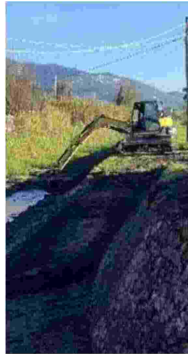
L'intervento dei tecnici del consorzio era finalizzato a risagomare l'alveo del corso d'acqua
