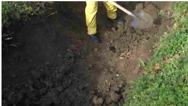
Un operaio ripulisce un fosso
