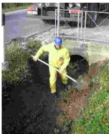
Un operaio ripulisce un fosso
